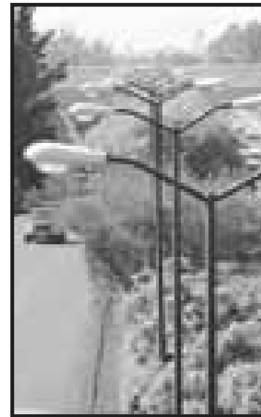
ILUMINAN LOS ACCESOS AL HOSPITAL REGIONAL Y EL CERESO.
